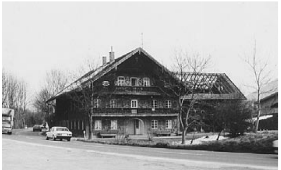
Er war der letzte Hof von St. Zeno an der rechten Seite der Straße nach Salzburg vor der Gemeindegrenze zu Marzoll. Der „Schafferbauer“ musste für den Neubau der Straße in den 90er Jahren umsiedeln, der alte Hof wurde abgerissen (Bild).
