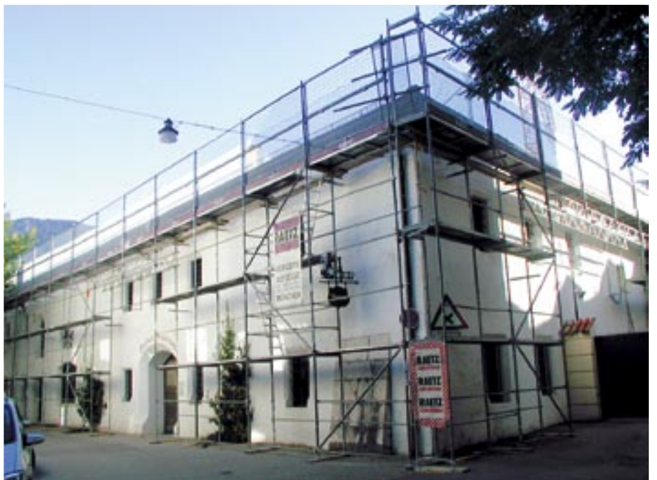
Das Bad Reichenhaller Heimatmuseum an der Getreidegasse ist zurzeit eingerüstet.
