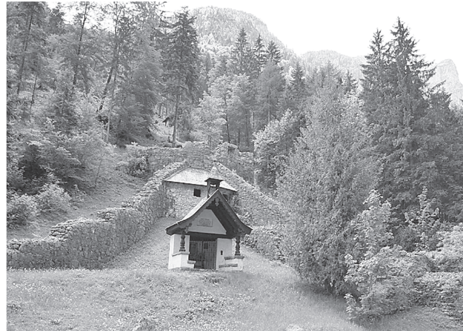
Die Reste der alten Befestigungsanlage „Salzburger Tor“ am Pass Strub.
